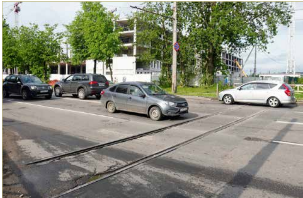
После демонтажа переезда около будущего кампуса начнётся реконструкция улицы Черепичной.
